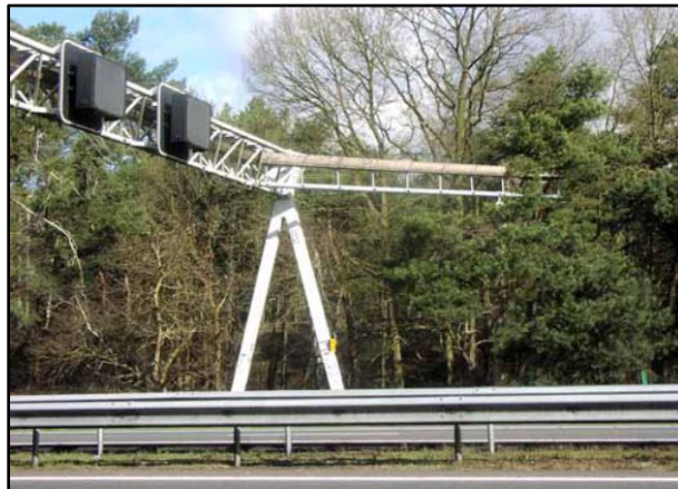
Gambar C.1 - Jembatan kanopi menggunakan bangunan perlengkapan permanen
