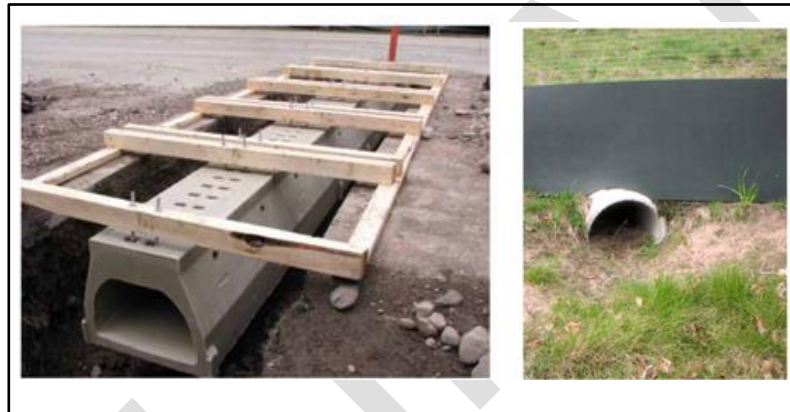
Gambar C.16 - Contoh konstruksi dan penempatan terowongan amfibi dan reptil
