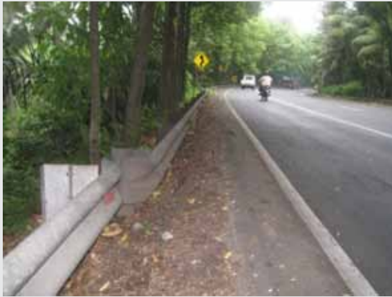
▲ Jarak dengan hazard tidak memadai Ujung fish tail Jeda tidak perlu
