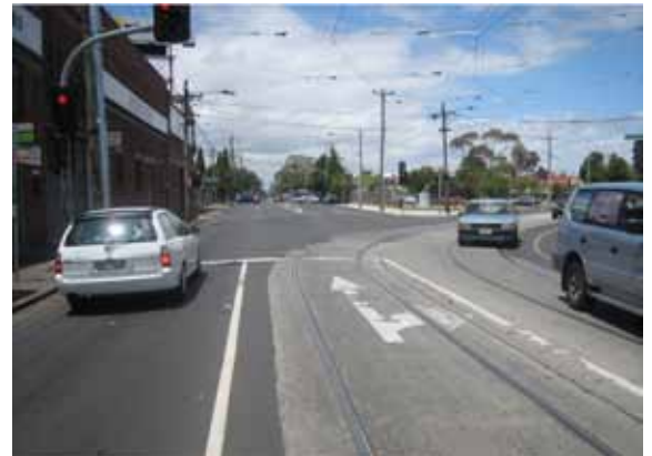
▲ Persimpangan Y ini telah dipasang APILL untuk mengendalikan pergerakan konflik. Pilihan untuk mengubah persimpangan ini menjadi persimpangan T tidak sesuai mengingat trem menggunakan dua pendekat.
