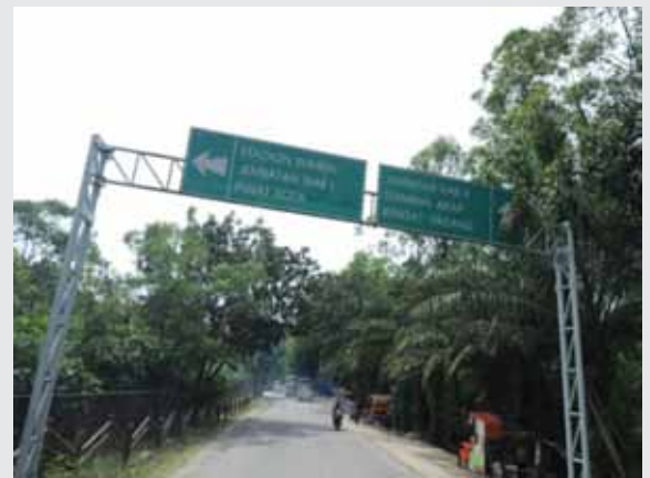
▲ Rambu petunjuk berada di atas jalan dua lajur. Namun, pengendara/pengemudi berpikir bahwa ini adalah jalan satu arah karena rambu menunjukkan seperti itu. Seharusnya rambu dilokasikan pada sisi kiri dari tiang. Marka garis tengah harus dibubuhkan di jalan.
