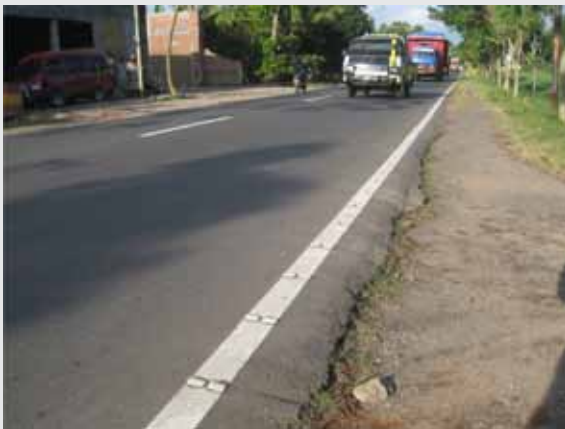
▲ Marka tepi berprofil memperingatkan pengemudi yang letih bahwa mereka akan keluar dari jalan. Adanya bahu jalan yang diperkeras akan menambah keuntungan dipasangnya marka jenis ini. Dalam kasus diatas, hampir tidak ada waktu bagi pengemudi untuk bereaksi sebelum mereka jatuh ke bahu yang tidak diperkeras (dan berbahaya).
