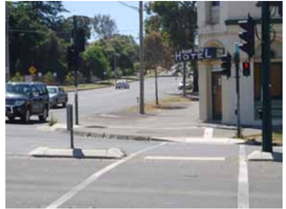
▲ Persimpangan dengan APILL yang membantu pejalan kaki. Terdapat marka yang jelas, cekungan pada kerb dan APILL pejalan kaki dengan tombol tekan. Pada median disediakan bukaan untuk lebih
