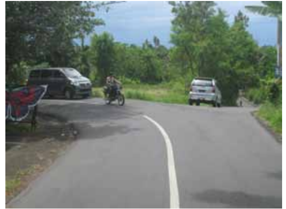
▲ Namun, ketika pengemudi/pengendara mendekati belokan, jalan terlihat lurus kedepan. Marka garis menunjukkan jalan utama belok ke kiri, namun tidak ada rambu arah yang membantu. Sebagian pengemudi/pengendara akan tahu jalan mana harus diambil. Lainnya tidak akan tahu jalan yang harus dilalui. Kebanyakan tidak akan tahu kendaraan mana yang mendapat prioritas di simpang tiga.
