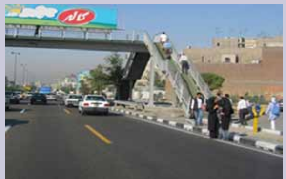
▲ Struktur jembatan pejalan kaki
