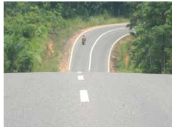
▲ Anda harus menghindari pandangan jalan yang diakibatkan kesalahan desain alinyemen vertikal - terutama ketika kurva horizontal berada dibalikny. Pada lokasi seperti ini, tiang pemandu perlu menyediakan delineasi memanjang. Pengemudi/pengendara akan dapat melihat puncak dari tiang melewati kurva jalan tersebut.
