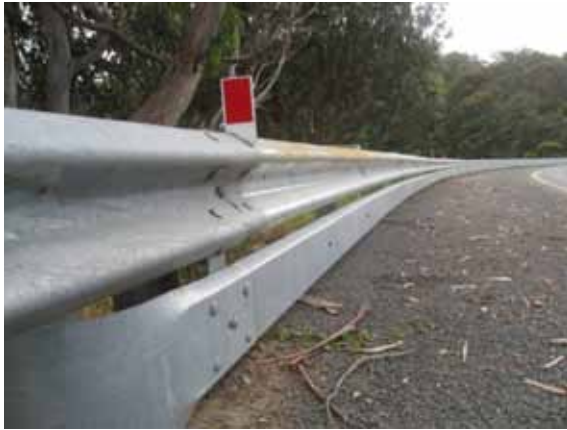
▲ Pagar tambahan yang dipasang dibawah guardrail dapat mencegah pengendara motor menabrak tiang guardrail. Tiang tersebut adalah penyebab luka parah bagi pengendara motor.
