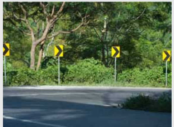
▲ Delineasi pada tikungan akan membantu pengemudi untuk tetap berada di jalurnya. Kebanyakan tikungan di Indonesia membutuhkan delineasi yang lebih tegas dan jelas. Rambu peringatan pengarah tikungan (CAMs) seperti pada gambar diatas, efektif untuk membantu pengemudi bernegosiasi dengan tikungan sub-standar.
