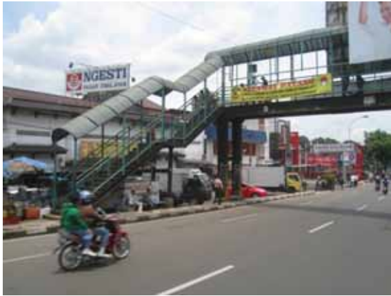
▲ Pejalan kaki jarang menggunakan jembatan penyeberangan orang. Bangunan ini cenderung menghalangi jalur pejalan kaki dan memaksa pejalan kaki untuk berjalan di badan jalan.
