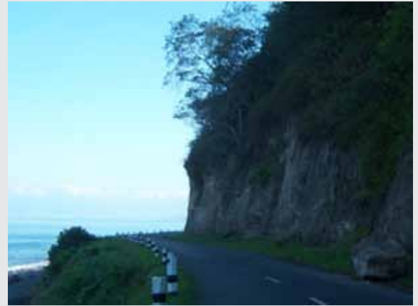
▲ Di medan yang sulit, perancang mungkin harus mengurangi lebar potongan melintang jalan. Dalam kasus ini lajur selebar 2,75 m dan tidak ada bahu jalan. Pada situasi seperti ini, demi keselamatan harus ada delineasi tegas (patok pengarah dan marka garis) dan yang terpenting kecepatan operasional dijaga cukup rendah.
