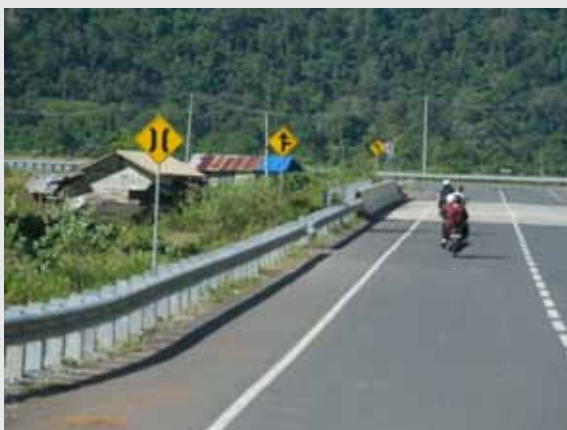
▲ Rambu peringatan jembatan yang tidak diperlukan - potongan melintang jembatan sama lebar dengan jalan.
