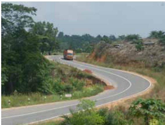
▲ Tikungan majemuk dengan kurva vertikal membutuhkan desain yang hati-hati untuk memastikan jarak pandang henti.
