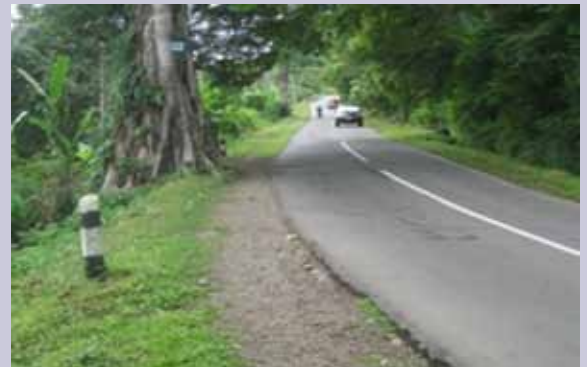
▲ Pohon besar; kemiringan sisi jalan yang tidak bisa dilalui
