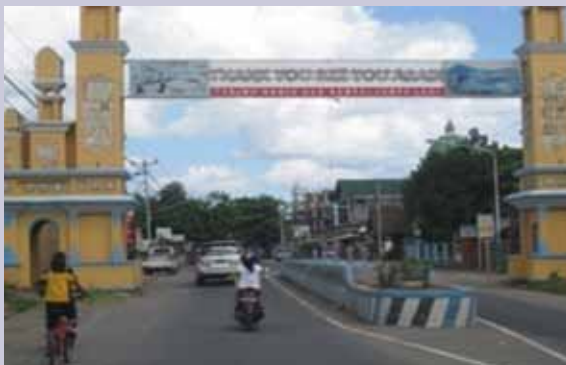
▲ Kerb tinggi pada pulau di lengkung jalan
