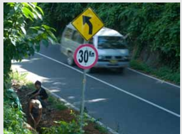
▲ Jangan mencampur rambu peringatan dengan rambu peraturan. Jika 30 km/jam adalah kecepatan yang dianjurkan, gunakan papan tambahan berwarna hitam kuning di bawah rambu peringatan kurva.
