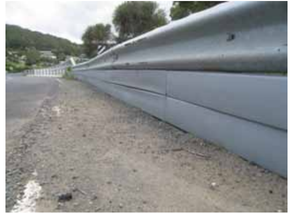
▲ Beberapa pagar tambahan terbuat dari plastik sehingga dapat menahan tumbukan dan menghindari tertabraknya tiang oleh pengendara motor.
