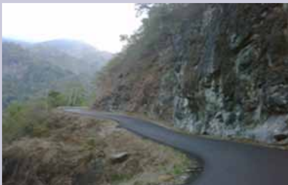
▲ Kemiringan yang curam tapi tidak ada delineasi atau marka jalan.
