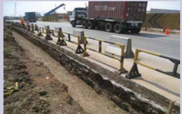
▲ Barikade beton yang tidak tersambung, barikade baja, dan galian sedalam 1 meter.
