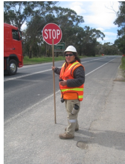
Petugas pemandu lalu lintas pada lokasi pekerjaan jalan menggunakan rompi berwarna terang.
