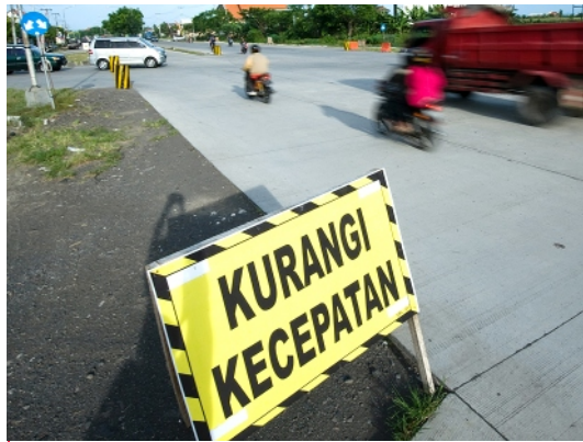
Penggunaan rambu peringatan dini yang benar pada pekerjaan jalan sangat penting untuk keselamatan pekerjaan jalan.
