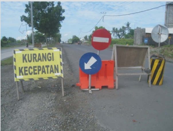
Terlalu banyak rambu dan ditempatkan berdekatan. Hal ini dapat menyebabkan pengemudi bingung.
