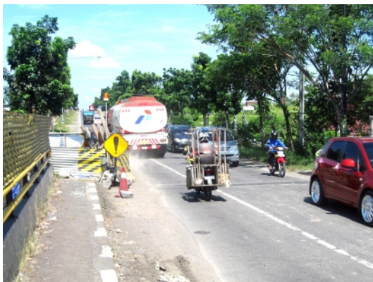
Lalu Lintas melewati Zona Kerja
