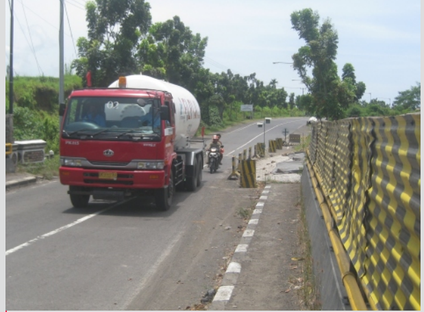
Lebar lajur berkurang banyak, tetapi lalu lintas tidak diatur berkeselamatan melalui titik menyempit.
