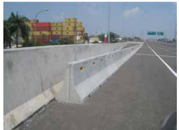
Gambar 3.35 Pagar beton sementara telah tersambung dengan baik. Namun ujung dari pagar ini adalah hazard bagi penumpang kenderaan yang lepas kendali. Pagar permanen di belakangnya bahkan dapat mengarahkan kenderaan lepas kendali pada ujung tumpul ini.
