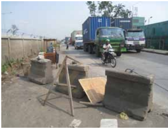
Gambar 3.30 Balok beton ini tidak berkeselamatan. Balok beton ini TIDAK boleh digunakan di jalan.
