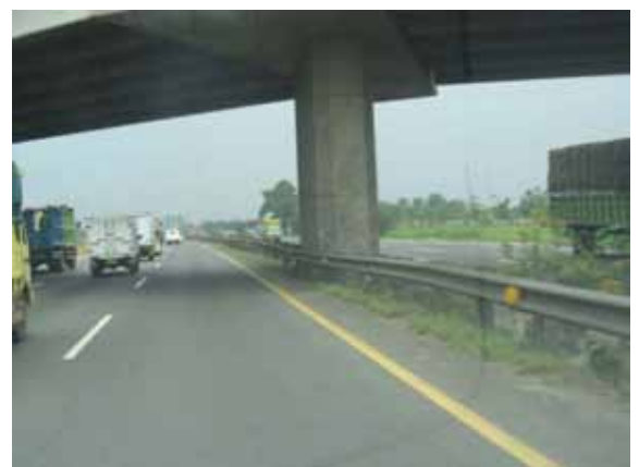
Gambar 3.12 Pagar keselamatan kaku lebih cocok diletakkan berdekatan dengan tiang jembatan untuk jalan tol/bebas hambatan dengan median yang sempit.
