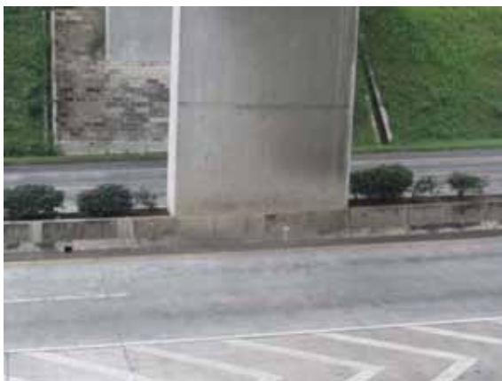
Gambar 3.11 Pagar semikaku dengan tiang jembatan ini tidak memiliki cukup ruang untuk berdefleksi saat tabrakan. Membuat kaku pagar dekat tiang dapat meningkatkan kinerja pagar dalam menahan tabrakan.
