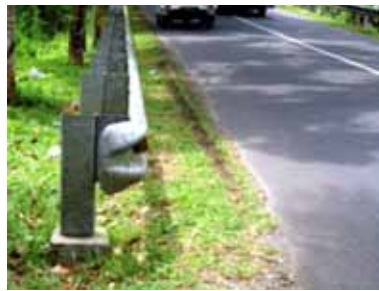
Gambar 4.5 Ujung pagar yang tidak ditutupi merupakan bahaya 'menusuk'. Ujung "fish-tail" memang meningkatkan keselamatan, namun sekarang merupakan penanganan yang kuno karena juga dapat menusuk ke dalam kendaraan. Pemasangan pagar keselamatan ini dapat ditingkatkan dengan menyediakan pagar keselamatan yang tepat yang sudah diuji kinerjanya.
