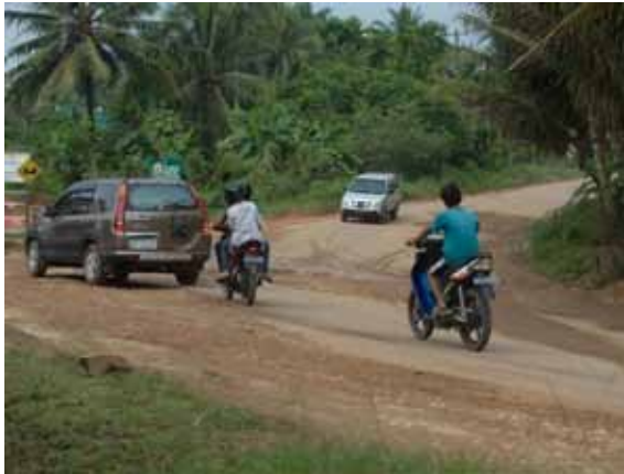
Gambar 2.5 Tanah di permukaan jalan dapat menyebabkan kendaraan tergelincir, meluncur, dan kehilangan kendali.
