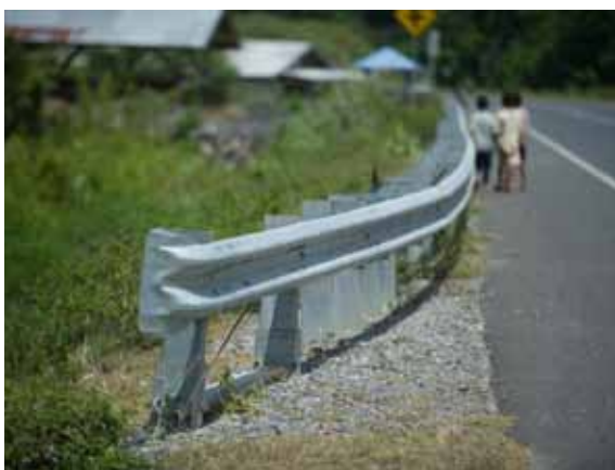
Gambar 3.19 Terminal pagar semikaku yang membengkok. Bahu jalan harus diperkeras ke pagar keselamatan - hal ini berlaku untuk sebagian besar panjang tapi terminal yang membengkok ke luar dari sisi jalan harus juga memiliki bahu jalan yang diperkeras.
