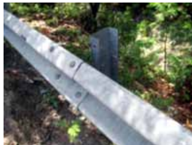
Balok yang berfungsi sebagai penyokong pagar jika hilang maka akan memengaruhi kinerja terhadap kecelakaan.
