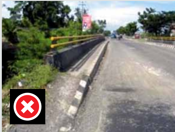
Gambar 1.4 Contoh hazard sisi jalan di ujung pagar keselamatan yang salah dan benar
