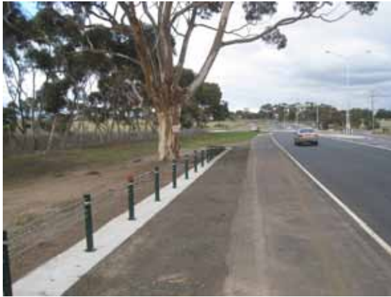
Gambar 3.23 Pagar keselamatan kabel baja, dengan ujung terminal di kejauhan
