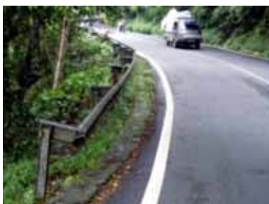
(c) Bagian pagar keselamatan dengan tiang-tiang yang sudah rapuh dan ketinggalan jaman tidak bisa diharapkan berfungsi secara memadai dalam kecelakaan.
