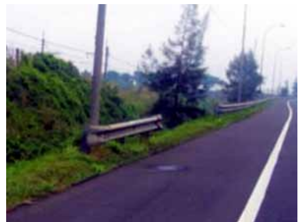
Gambar 3.16 Pagar keselamatan untuk hazard tiang ini tidak efektif untuk kendaraan yang keluar jalan pada tipikal sudut (sampai dengan kira-kira 22 derajat). Panjang pagar juga tidak memadai. Tiang yang frangible (jatuh tidak membahayakan jika ditabrak) akan lebih memadai. Saluran yang dapat dilalui kendaraan akan lebih lunak dan berkeselamatan bagi kendaraan yang lepas kendali.
