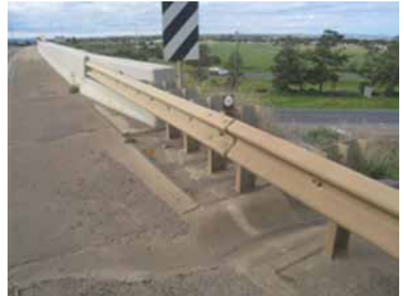
Gambar 3.26 Sambungan pada sisi depan awal dari pagar baja profil-W ke parapet kaku jembatan.
