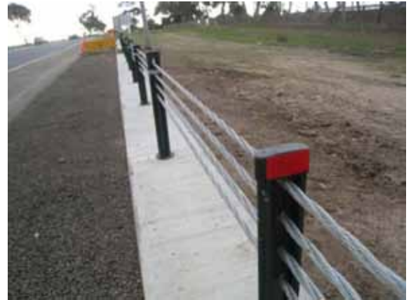
Gambar 3.3 Pagar Keselamatan Fleksibel 'Wire rope'
