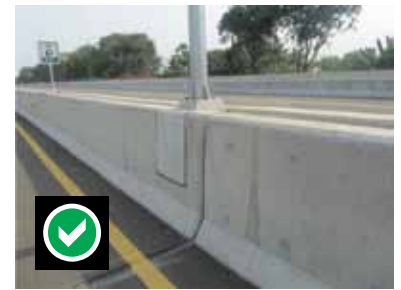
Tiang lampu ini dipasang pada bagian atas pagar. Hal ini untuk tetap mempertahankan pagar yang berkesinambungan.
