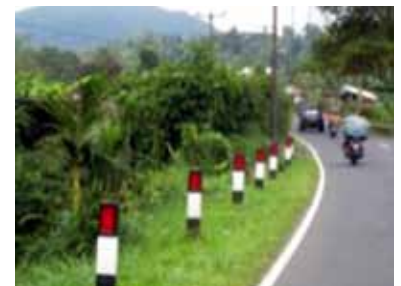
Patok-patok pengarah kaku yang menutupi keberadaan lereng/tebing. Keselamatan akan meningkat dengan mengurangi kemiringan lereng atau memasang pagar keselamatan.
