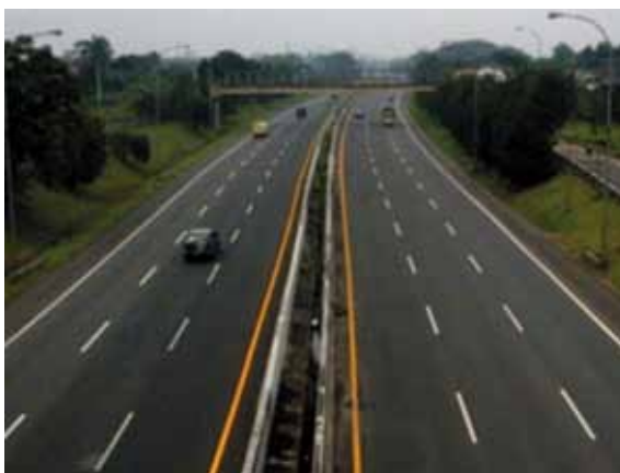
Gambar 2.13 Pembatas yang baik dengan garis lajur dan garis tepi di jalan tol.
