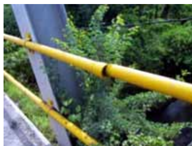
Pagar pada jembatan perlu dipelihara sehingga dapat terus-menerus berfungsi dengan baik. Ujung pagar juga berpotensi menciptakan bahaya 'tertusuk' jika terjadi benturan/tumbukan.
