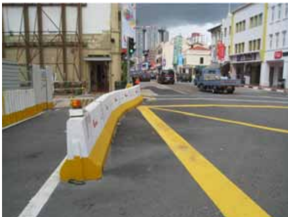
Gambar 3.34 Ujung dari pagar beton sementara yang tumpul ini digeser ke luar area bebas (area bebas kira kira 3 meter dari tepi lajur terdekat). Ini merupakan pilihan yang berkeselamatan untuk ujung pagar sementara.
