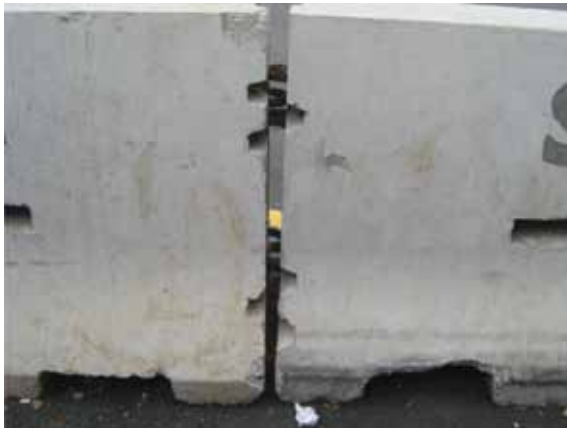
Gambar 3.32 Kedua pagar kaku sementara terpasang dengan baik dan tersambung dengan kokoh. Setiap balok memiliki "kaki" didasarnya sehingga air hujan dapat mengalir di bawahnya.
