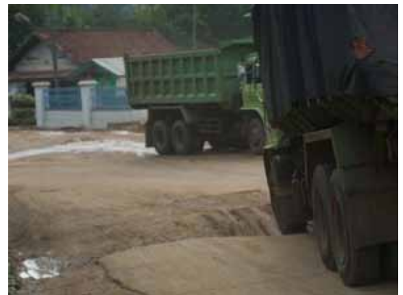
Gambar 2.4 Lubang jalan dapat menyebabkan pengemudi/pengendara kehilangan kendali, khususnya pengendara motor.
