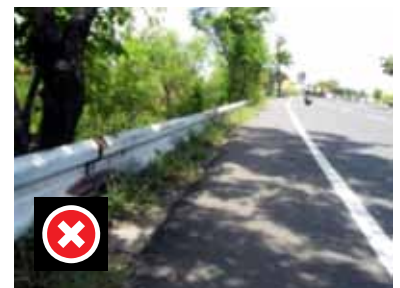
Tumpukan sambungan yang salah Terlalu rendah Tidak cukupnya jarak ke hazard pohon
