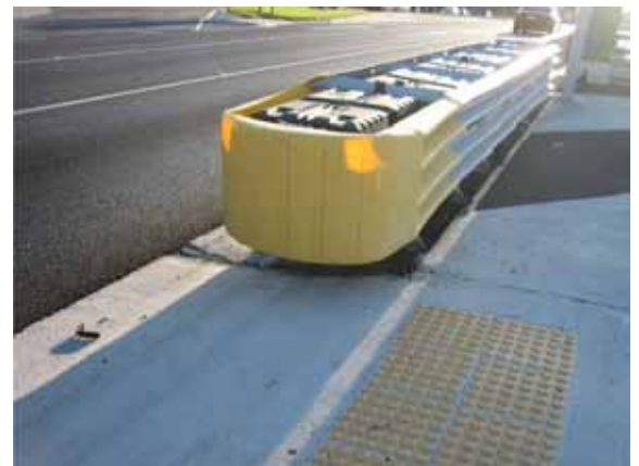
Gambar 3.24 Ujung pagar beton ditutupi dengan Bantalan Tabrakan.
