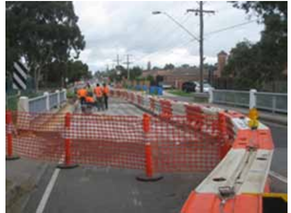
Gambar 3.37 Pagar berisi air tersambung dengan benar sehingga melindungi pekerjaan di jalan. Batas kecepatan dikurangi untuk meminimalkan risiko. Ujung pagar dibengkokkan ke luar area bebas agar ujung pagar tidak menjadi hazard.
