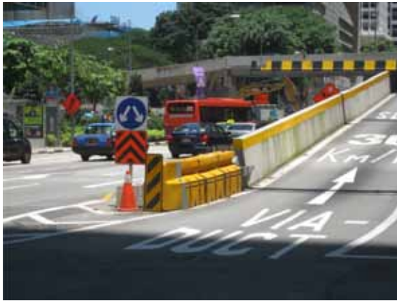
Gambar 3.36 Bantalan tabrakan berbiaya murah merupakan salah satu opsi sebagai terminal berkeselamatan pagar kaku sementara.
