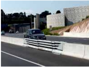
Gambar 4.6 Pagar besi seperti pada contoh ini telah diuji TL-3 untuk menutup median di jalan berkecepatan tinggi. Ketika bukaan diperlukan dalam keadaan darurat atau untuk pemeliharaan, petugas jalan yang berwenang membuka kunci pagar dan meminggirkannya.
