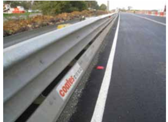
Gambar 3.33 Setiap bagian pagar beton sementara tersambung dengan kokoh membentuk pagar menerus. Lubang kecil di bawahnya memungkinkan aliran air dapat melalui pagar sehingga mereduksi genangan air di jalan.
