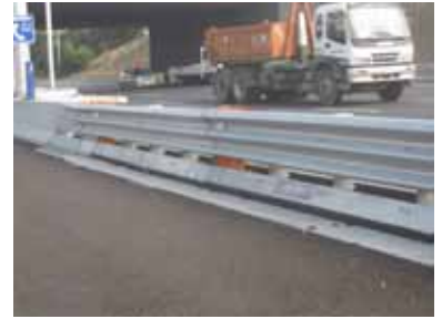
Gambar 4.6 Pagar besi seperti pada contoh ini telah diuji TL-3 untuk menutup median di jalan berkecepatan tinggi. Ketika bukaan diperlukan dalam keadaan darurat atau untuk pemeliharaan, petugas jalan yang berwenang membuka kunci pagar dan meminggirkannya.
