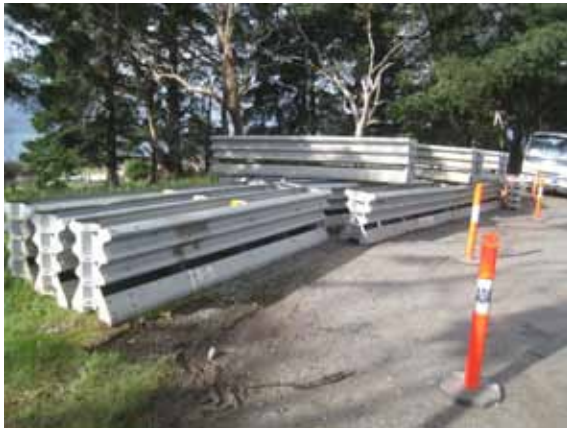
Gambar 3.32 Kedua pagar kaku sementara terpasang dengan baik dan tersambung dengan kokoh. Setiap balok memiliki "kaki" dasarnya sehingga air hujan dapat mengalir di bawahnya.
