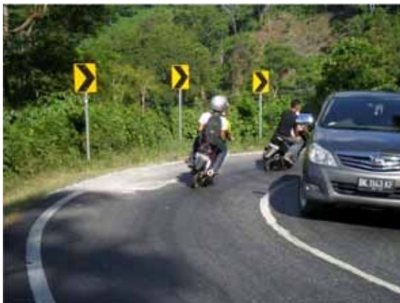
Gambar 2.11 Delineator (marka garis tepi dan chevron) yang jelas di tikungan
