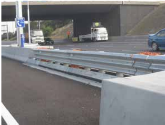
Gambar 3.28 Pagar baja yang telah memenuhi persyaratan uji internasional dan dapat digeser dari lokasi ini dalam waktu sekejap untuk menciptakan bukaan pada median pagar kaku.
