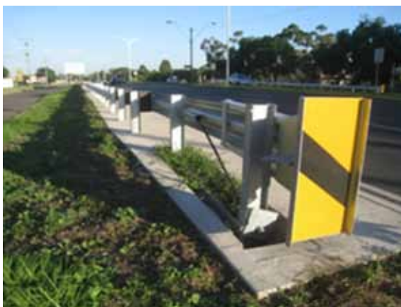
Gambar 3.21 Terminal non-bengkok untuk pagar profil - W.
