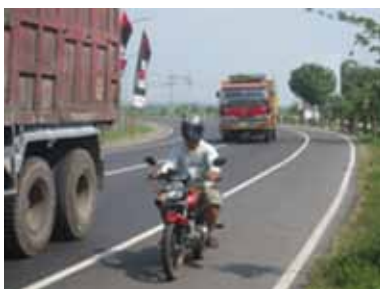
Gambar 4.12 Bahu yang diperkeras/diaspal memberikan lingkungan jalan yang lebih aman untuk pengguna jalan-terutama pengendara sepeda motor.
