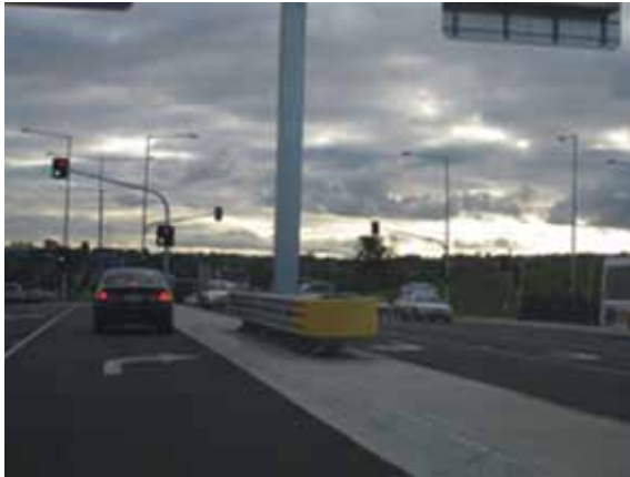
Gambar 3.25 Dua bantalan tabrakan "punggung ke punggung" menutupi tiang rambu besar di median sempit
