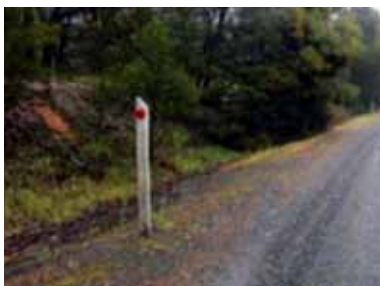
Contoh patok pengarah dari kayu yang mudah patah (kurang lebih 100 mm x 50 mm).
