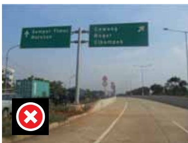
Gambar 4.2 Tiang rambu pada foto di atas berbahaya bagi kendaraan yang lepas kendali.
