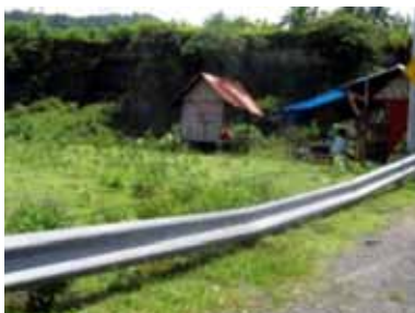
(b) Tiang-tiang yang hilang mempengaruhi kinerja pagar pembatas karena berpengaruh pada kekuatan dan tinggi pagar.
