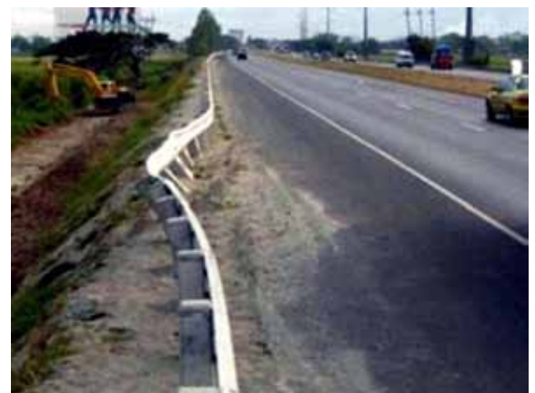
Gambar 3.13 Defleksi dari pagar keselamatan besi profil-W setelah tabrakan.
