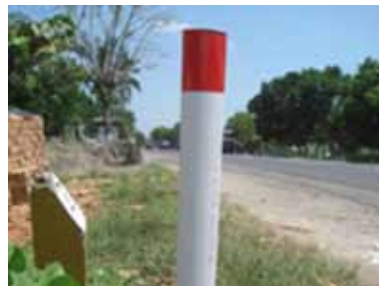
Patok pengarah plastik yang dibuat dengan memotong pipa PVC menjadi dua dan menempelkan reflektor di atasnya.
