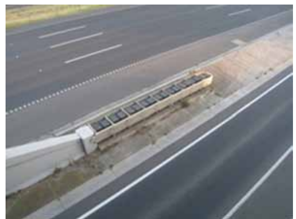
Gambar 3.22 Sebuah bantalan tabrakan digunakan untuk menutupi dinding beton di jalan bebas hambatan berkecepatan tinggi.
