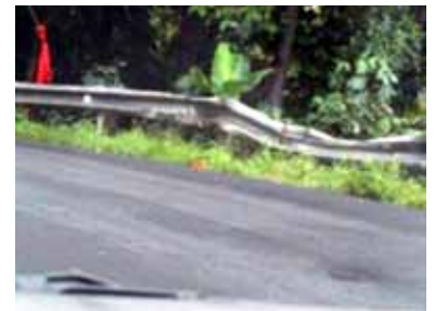
Pagar yang rusak tersebut tidak akan berfungsi dengan baik jika ditabrak lagi oleh kendaraan yang lepas kendali.
